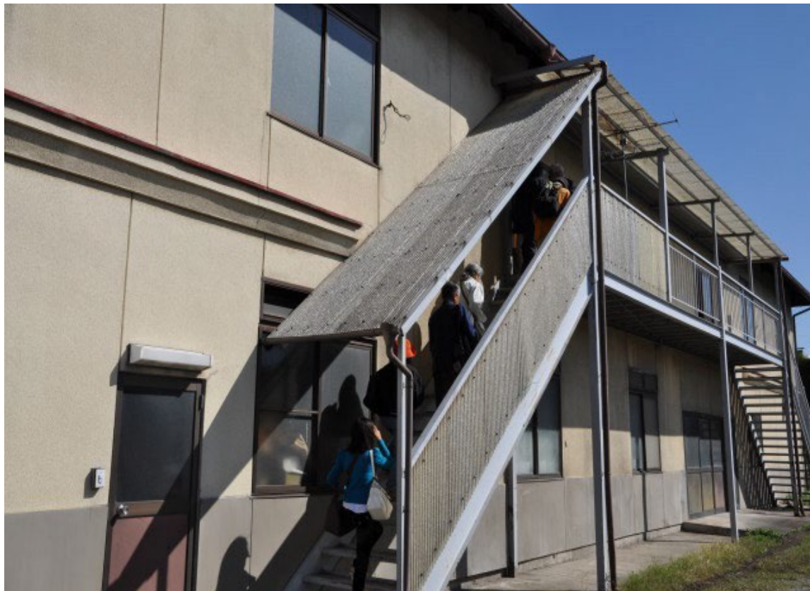
藤本蚕業歴史館(この建物の2階) 1927年築の藤本蚕業株式会社社屋 2009年10月開館
