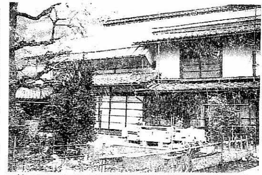
第4図 旧塚田与右衛門の家 茅葺き屋根の一部を改造して2階を蚕室 (昭和63年撮影)
