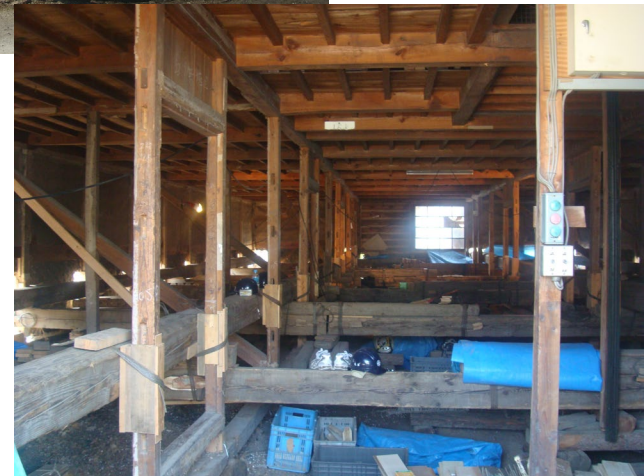
木造四階繭倉庫(曳家後)
